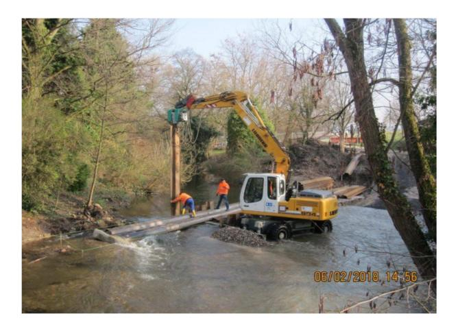
Wie man auf dem Foto unschwer erkennen kann, laufen die Arbeiten der Verlegung der Fernwärmeleitungen auf Hochtouren. Es wird gegraben, verlegt, geschweißt, gedämmt, verfüllt, gespundet, eine Straße durch die Alb gebaut usw.
